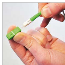
montaż obudowy SC/APC na złączu SC2
