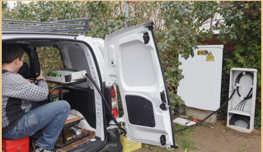
Fot.3. Spawanie włókien światłowodowych w przełącznicy MarsP.
